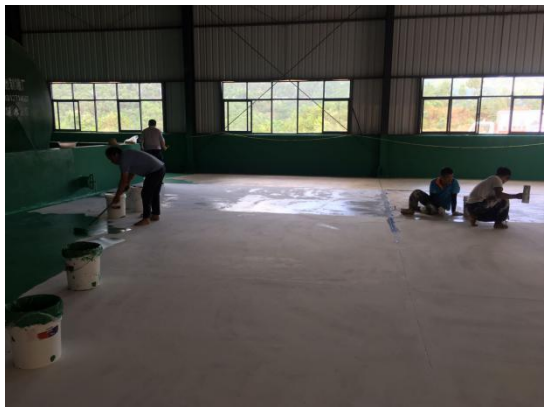
地面防渗施工
