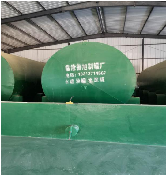
卸油口及废机油储存区围堰
